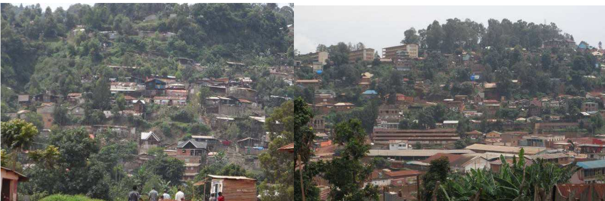
Photo 2. Construction sur sites impropres
